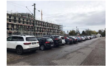
P+R-Anlage (nördliche Seite des Ditzinger Bahnhofs)
