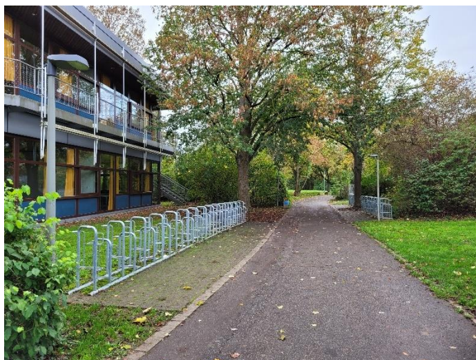
Abbildung 35: Fahrradparker als Vorderradhalter mit abwechselnder Hoch- und Tiefeinstellung
