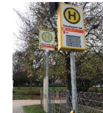
Fehlende Überdachung und Sitzmöglichkeit
