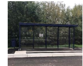
Haltestellendach mit Dachbegrünung
