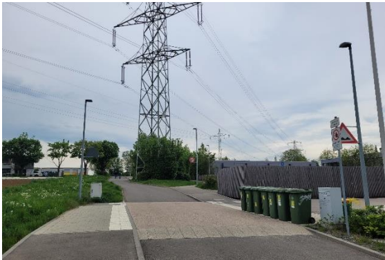
Abbildung 18: Teilaufpflasterung der Schwabstraße an der Theodor-Heuglin-Schule in Hirschlanden
