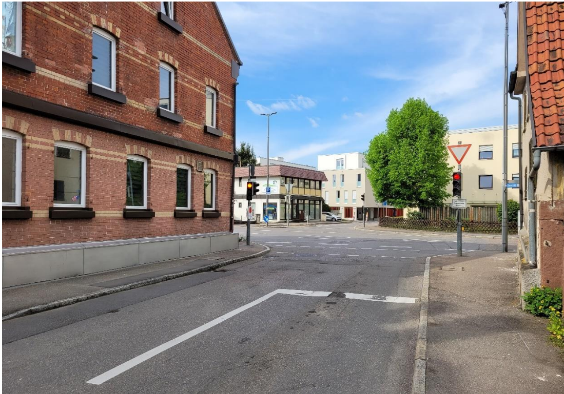
Abbildung 47: Glemsstraße in Ditzingen, signalisierte Kreuzung mit der Hirschlander Straße
