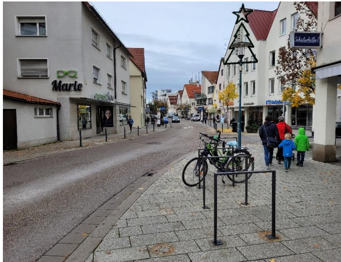
Abbildung 33: Anlehnbügel aus Flachstahl ohne Querholm in Doppelaufstellung in der Marktstraße in Ditzingen
