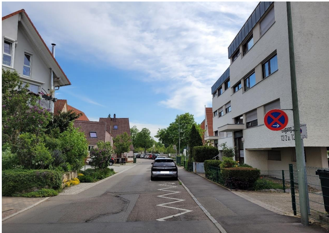
Abbildung 49: Glemsstraße in Ditzingen, schmale Fahrbahn, Blick in Richtung Osten
