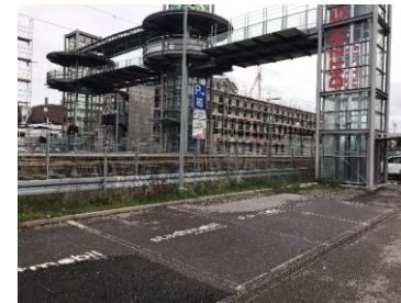
Aufzuganlage am Ditzinger Bahnhof
