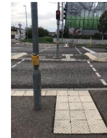
Taktile Leitsystem an einer Querungsanlage
