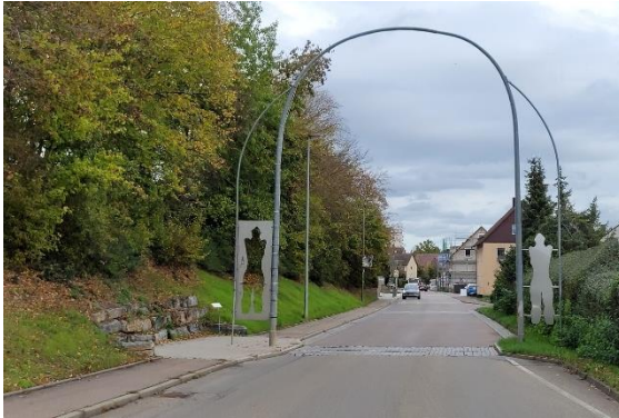
Abbildung 16: Fahrbahnverengung der Heimerdinger Str. am westlichen Ortseingang von Hirschlanden
