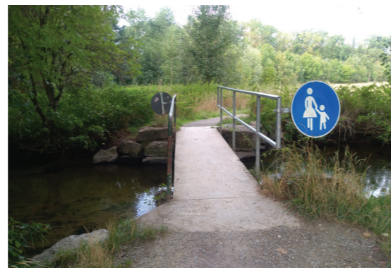
Abb.31 Brücke über die Glems, Foto: ISA
