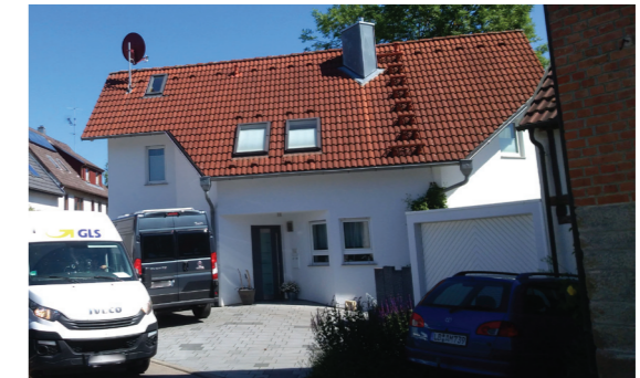
Abb.139 Einfamilienhaus und Parksituation
