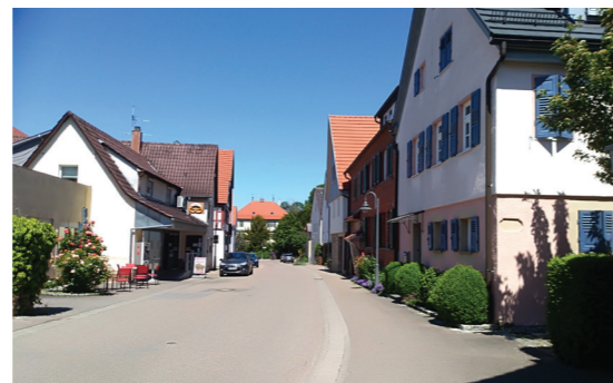
Abb.125 Blick von Ritterstraße Richtung Nordosten
