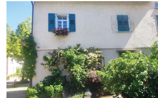
Abb.127 Fassaden und Wandbegrünung
