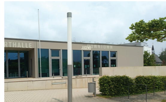
Abb.154 Sporthalle Weissacher Straße
